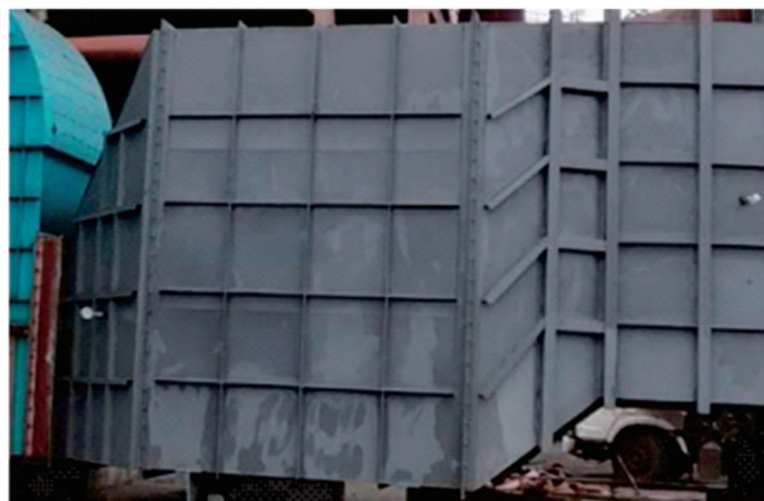
◆改造前出口管道
